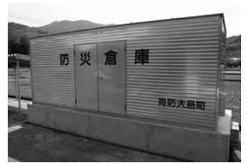
▲防災用品を備蓄している防災倉庫
