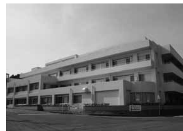
▲第1期工事が終了した東和病院 3月末までに工事が完了する予定です。
