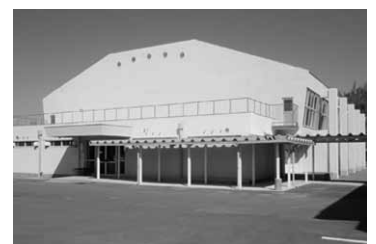
▲東和中学校屋内運動場改修工事
