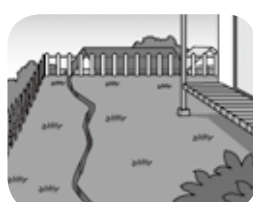
・地面にひび割れが入る
