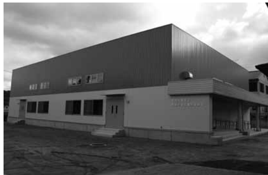
▲明新小学校屋内運動場
