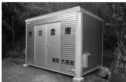
▲防災備蓄倉庫（笠佐島）
