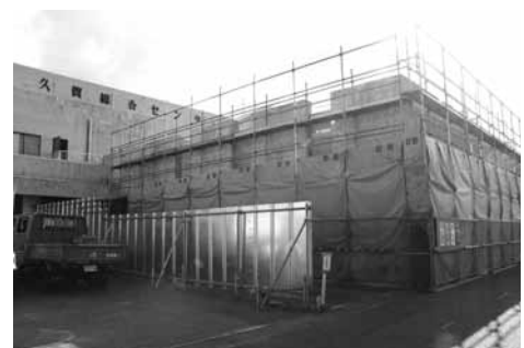
▲改修工事の進む久賀公民館
