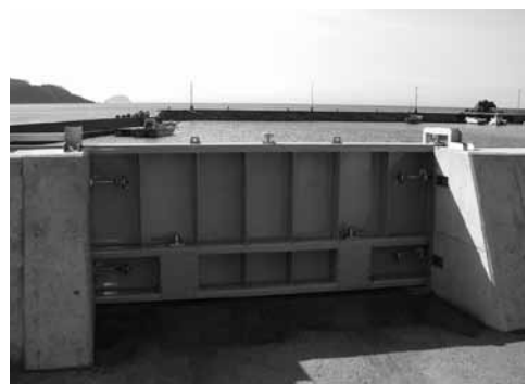
▲漁港陸閘整備事業（地家室）
