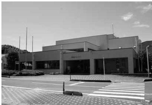
▲ 空調設備などが改修される橘総合センター
