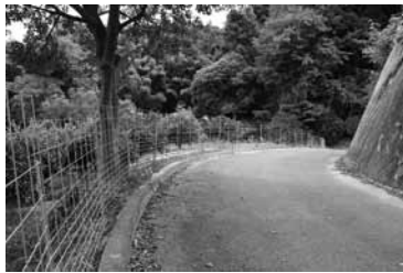
▲棲み分けを狙い設置された防護柵 (久賀・久保河内地区)
