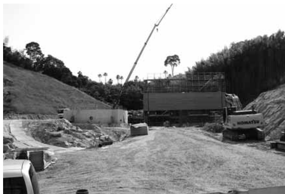
▲建設が進む長浦の終末処理場
