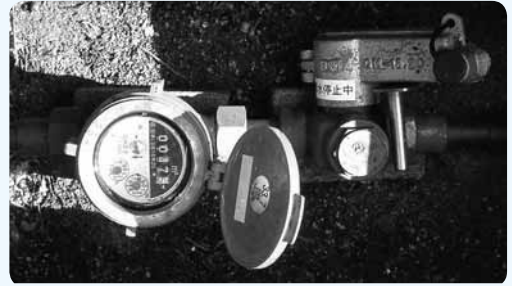
閉栓キャップによる給水停止
