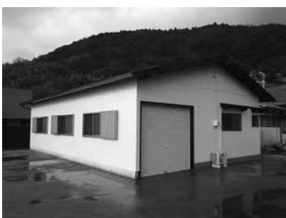
▶完成した小積作業所
