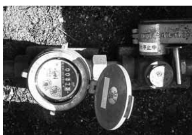
▲閉栓キャップによる給水停止
