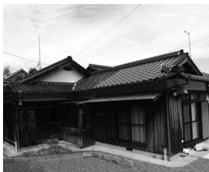
▲木造平屋建 94.25㎡（約28.5坪）
