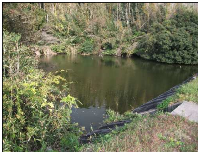
写真：峠ため池
