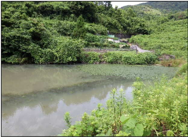
写真：樋ノ口ため池（下流より撮影）
